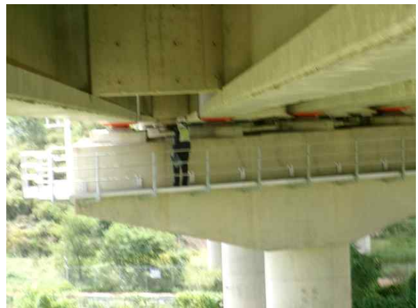
도보를 이용한 근접조사
